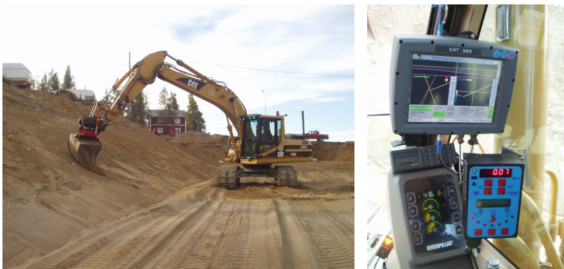
Figur 7: Exempel på maskinstyrningssystem
